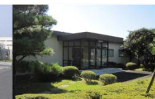
A棟(ウラン系分析・ 試験施設)
