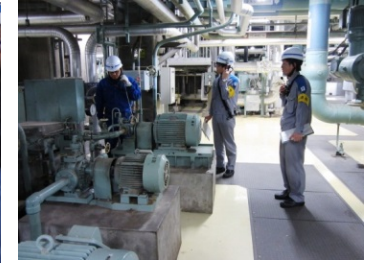
(現場作業の様子)
